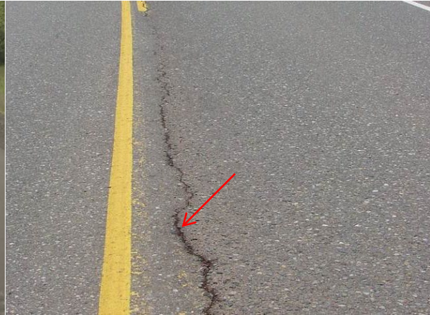
Left edge – low severity
